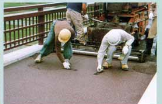
自然石舗装の新設や補修
