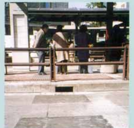
コンクリート舗装の不陸整正や補修
