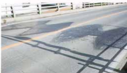
橋梁ジョイントの段差補修や不陸整正
