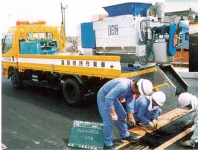
橋梁の埋設ジョイントの施工
