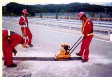
⑤ 敷均し、転圧
