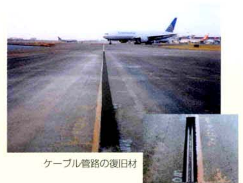
後打コンクリート部の補修
