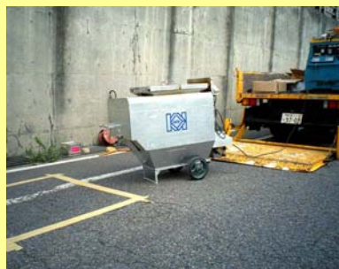
①機械の設置
